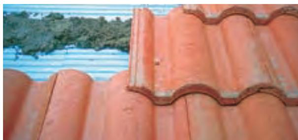
ROOFMATE PT-A – Aplicação de telha com cordões de argamassa
